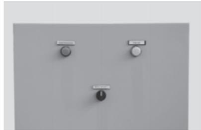
Figura 7: Chave seletora na posição “0” (desliga)
