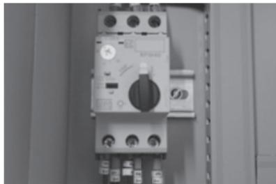
Figura 8: Posição do disjuntor no painel
